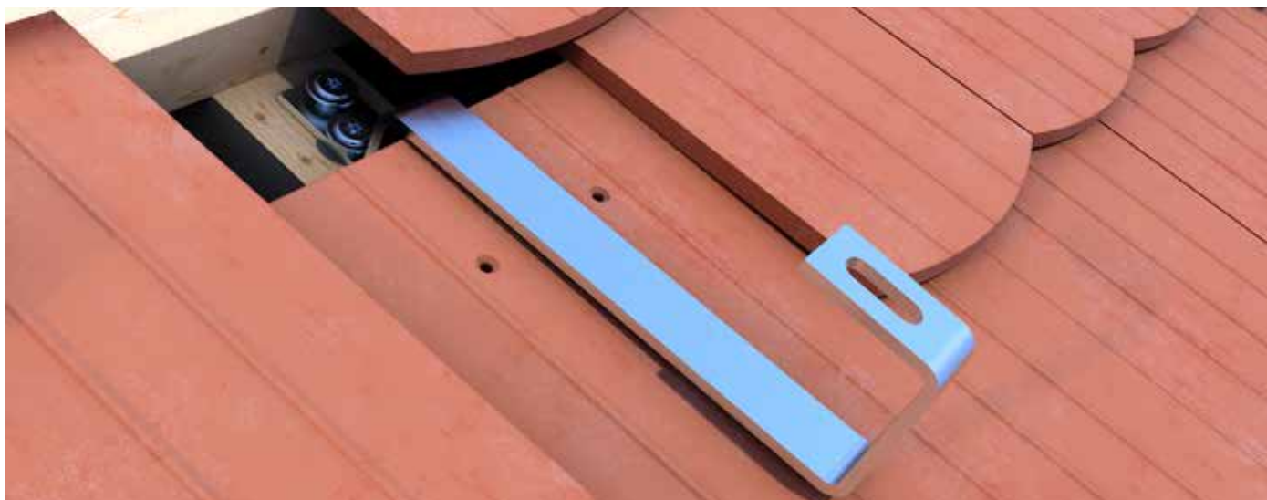
Dachhaken Biberschwanz an der Konterlatte montiert und mit Biberschwanzziegel eindecken.
